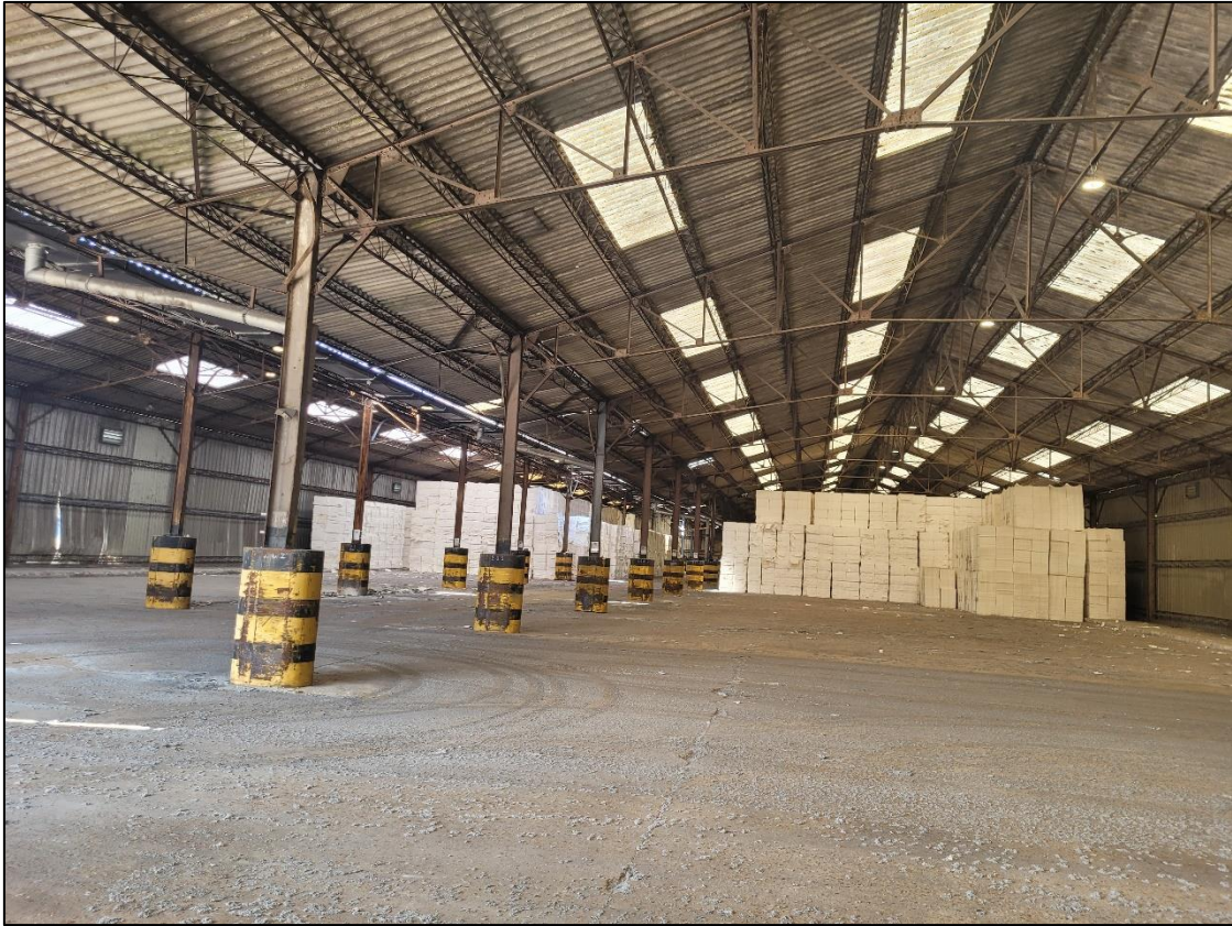
Figure 31. Bâtiment existant SPF1
